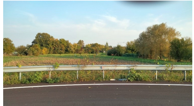
Corridoio infrastrutturale II stralcio lotto 2 asse 2 vista da rotatoria n. 3
