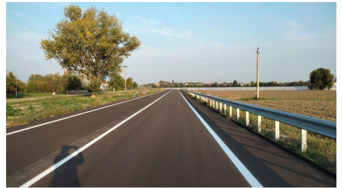
Il stralcio lotto 1 all'altezza del caseificio dismesso
