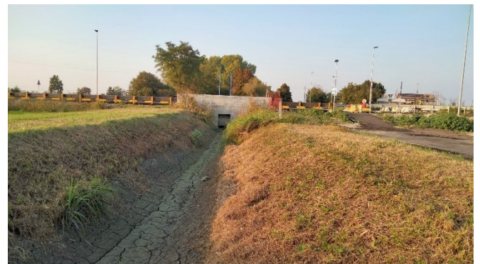
Attraversamento Canale dei Mulini . vista da sud
