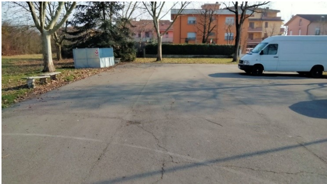
Parcheggio pubblico mapp. 291 ed edifici urbani sul confine est
