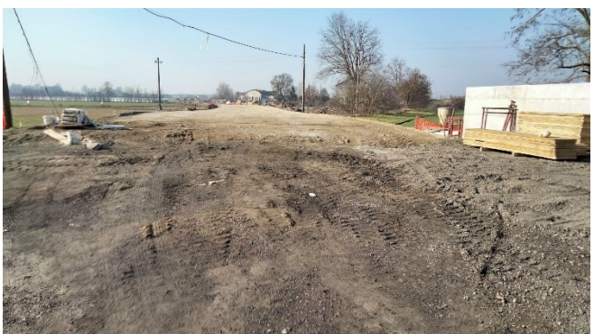
Piano strada in attraversamento canale dei mulini – vista verso ovest
