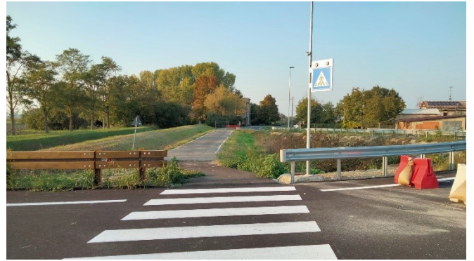
Percorso pedonale in sponda dx del Canale dei Mulini vista verso Nord
