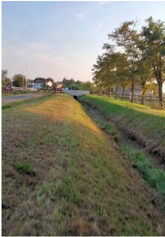
Attraversamento Canale dei Mulini visto da Nord
