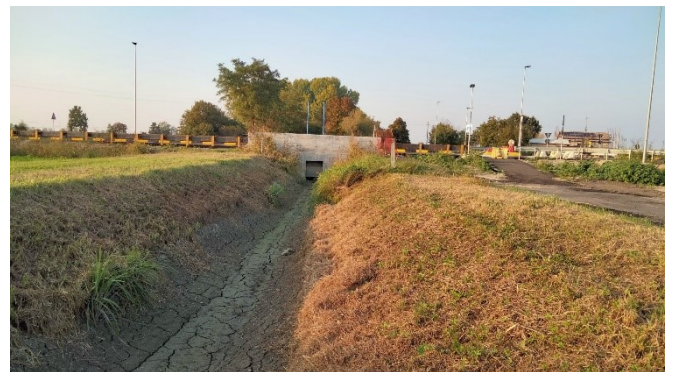
Attraversamento Canale dei Mulini . vista da sud
