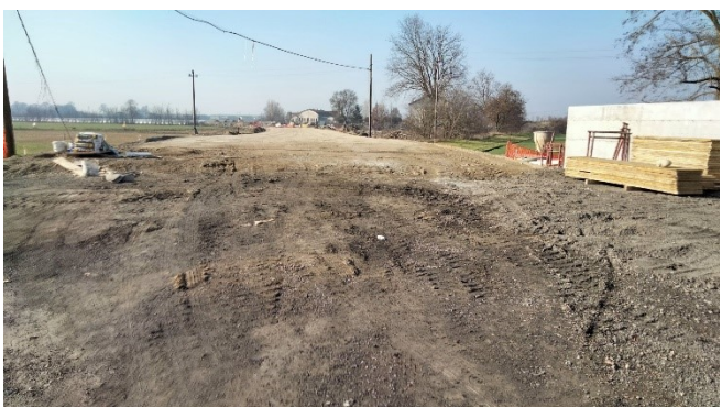
Piano strada in attraversamento canale dei mulini – vista verso ovest
