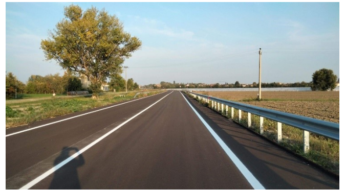
Il stralcio lotto 1 all'altezza del caseificio dismesso
