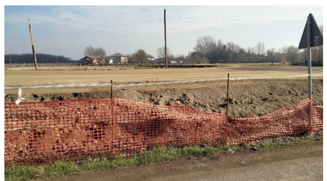
Rotatoria 3 da argine canale dei Mulini verso est
