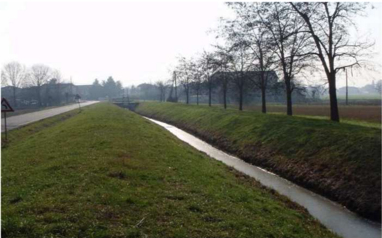
Foto 1. Canale dei Mulini e Via Valle - direzione sud
