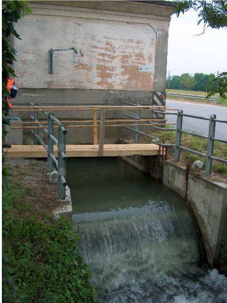
Figura 6. Lo sfioratore de La Camera. Vista da valle durante la prova.
