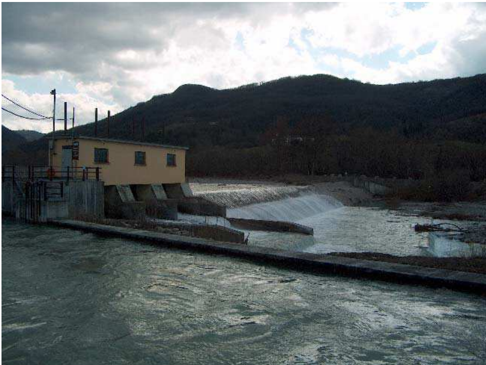
Figura 1. La Traversa di Cerezzola
