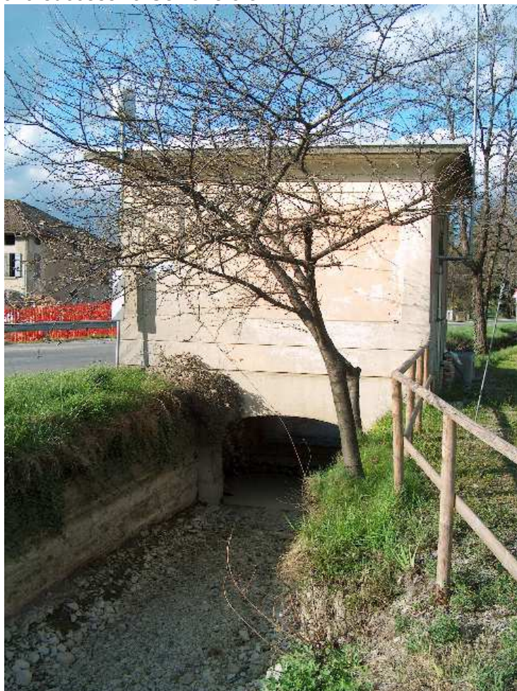
Figura 5. Lo sfioratore de La Camera. Vista da monte.
