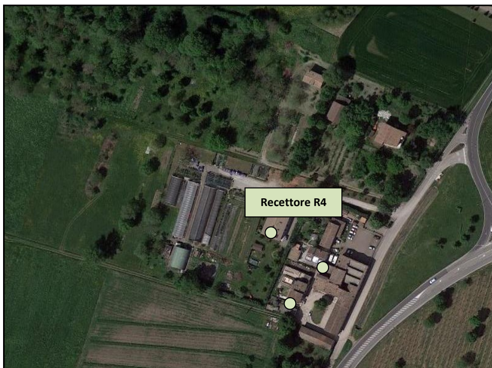
Figura 3: vista aerea (individuazione del recettore R4)
