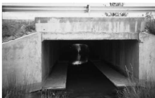
Figura 4: Esempi di scatolari con passerelle laterali per il passaggio di fauna di piccole dimensioni. Fonte: Progetto definitivo superstrada a pedaggio pedemontana veneta.
