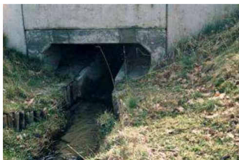
Figura 4: Esempi di scatolari con passerelle laterali per il passaggio di fauna di piccole dimensioni. Fonte: Progetto definitivo superstrada a pedaggio pedemontana veneta.
