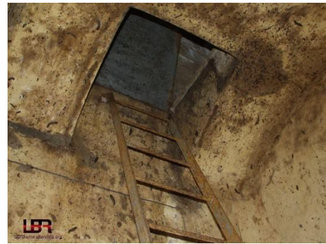
Fig. 04: scala di accesso
