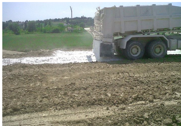
Figura 5.2- Esempio di stesa di UNIROAD SPTM
