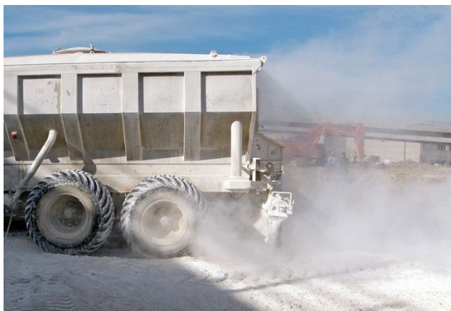
Figura 5.1- Esempio di stesa di ossido di calcio tradizionale
