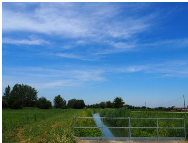
Img. A.14 - Viste del torrente Rodano in corrispondenza del manufatto di scavalco da parte del Canale di Secchia
