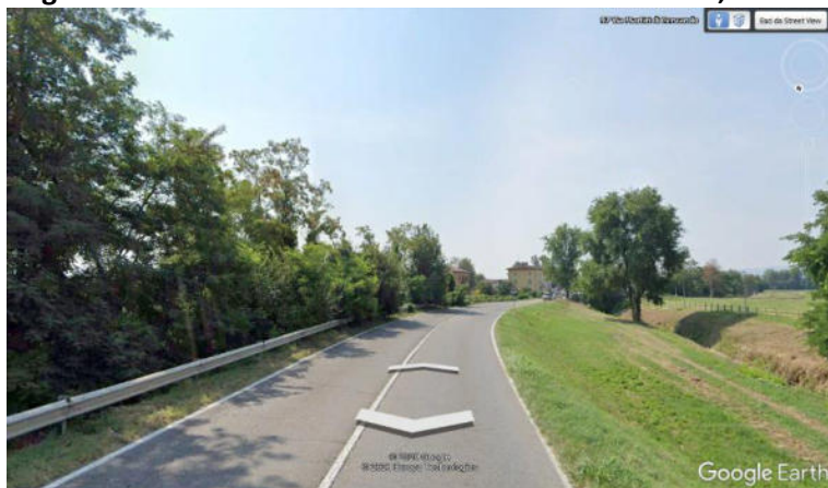
Img. A.40 - Vista della SP 467R a Due Maestà, in direzione sud
