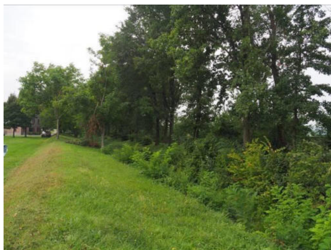
Img. A.12 - Viste delle opere di collegamento tra torrente Lodola e canale di Secchia
