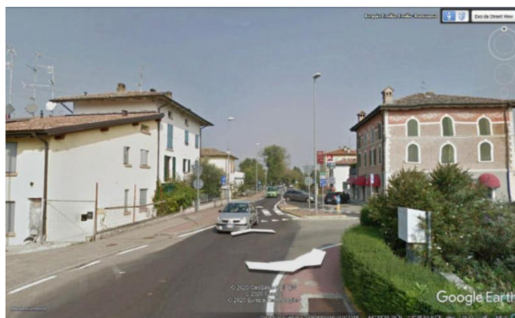
Img. A.54 – Viste del “Centro Storico e nuclei di impianto storico” individuato nel nucleo storico di Due Maestà, con una “Architettura del primo ‘900: edificio di valore tipologico”
