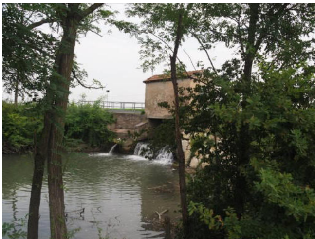
Img. A.13 - Vista del Canale di Secchia a sud del manufatto di scavalco del rio Rodano
