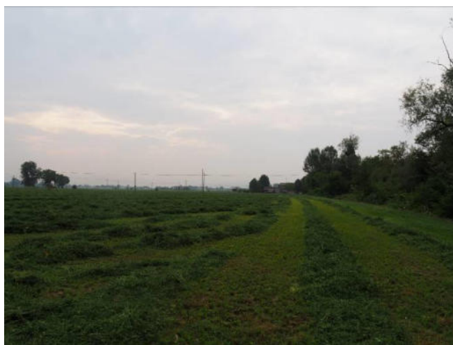
Img. A.11 - Vista dell'argine del torrente Lodola a sud del collegamento con il canale di Secchia
