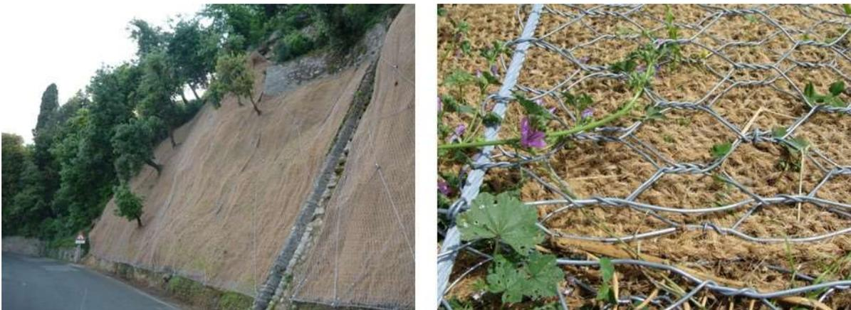
Figura 19 – Esempi di geo composito anti-erosivo, a sinistra, geo composito armato.
