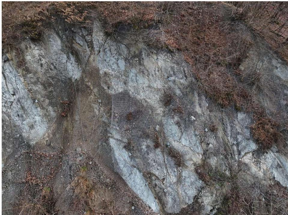
Figura 12 – Parete a monte della SP 513R al limite ovest dell'area di interesse. Notare presenza di rafforzamenti corticali da sostituire.
