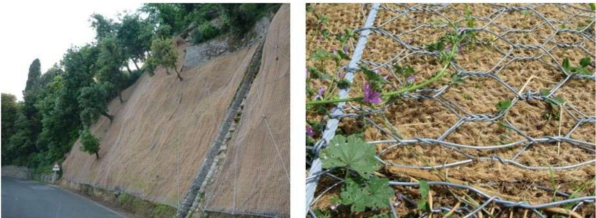
**Figura 3 – Esempi di geo composito anti-erosivo, a sinistra, geo composito armato.**
