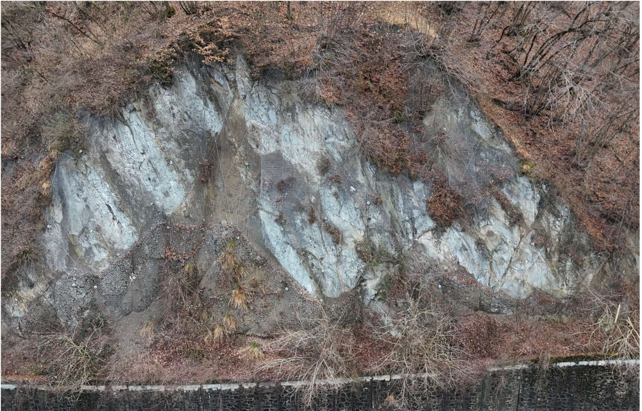
Figura 1: panoramica del settore da rivestire
