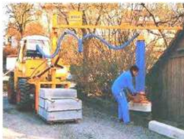
IMPIEGO MACCHINA POSA CORDOLI
