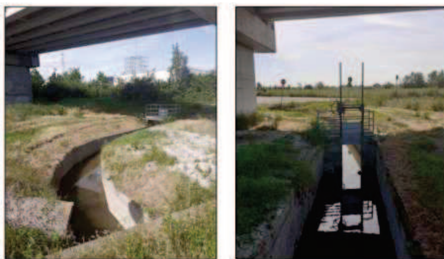
Figura – Condotto Gazzata sotto sovrappasso autostradale (fonte Studio Progeo)
