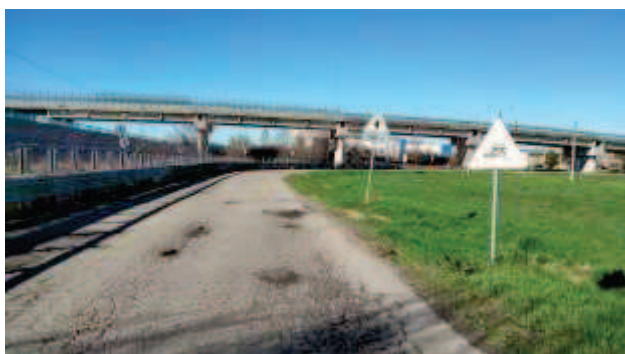
Vista da est di via San Pellegrino Nord nel punto di intersezione con la Bretella
