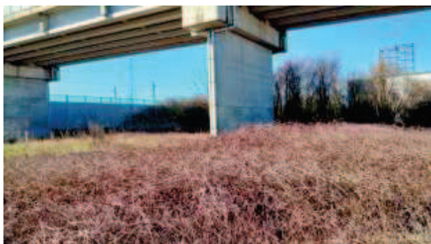
Punto di passaggio della Bretella sotto al cavalcavia ferroviario e autostradale
