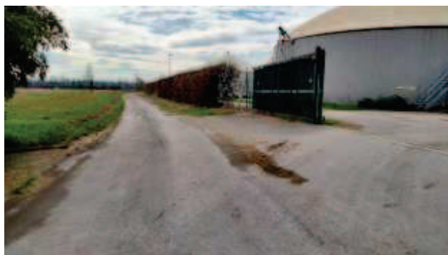
Via Casoni nei pressi dell'impianto di biometano
