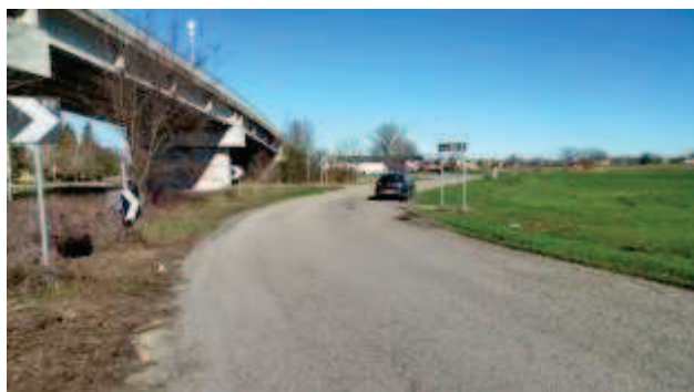
Incrocio a raso tra via San Pellegrino nord e via Camuncoli
