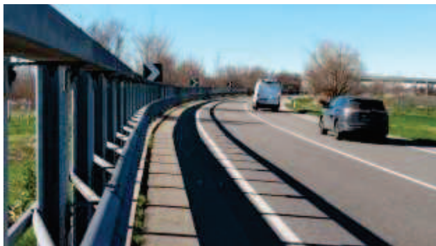
SP 113 – punto d'innesto rotonda ovest vista verso ovest
