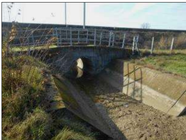
Figura 33 – Attraversamento ad ovest dello stabilimento Veroni Cotti Srl.
