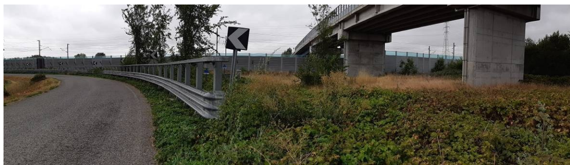
Nuova bretella, Loc. Gazzata, San Martino in Rio (RE): limite orientale dell'intervento di sotto al cavalcavia di Via Cà Matte Sud, sulla sinistra Via San Pellegrino Nord (UR6)
