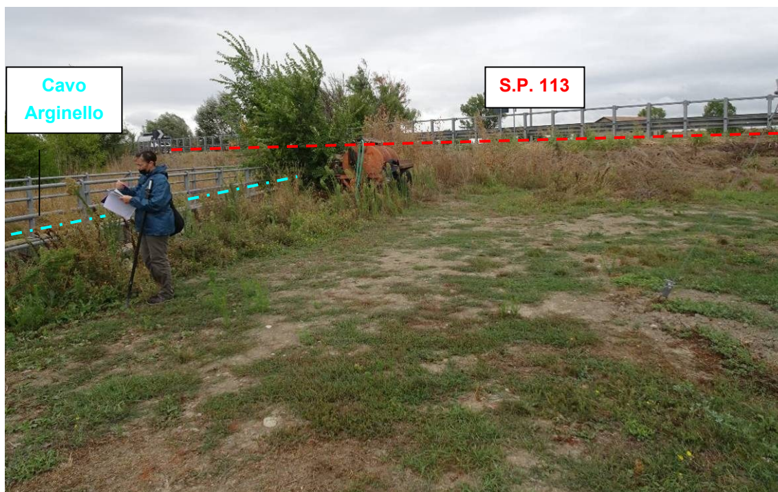
Nuova bretella, Loc. Gazzata, San Martino in Rio (RE): area della rotonda con la S.P. 113 (foto da sud) (UR1)
